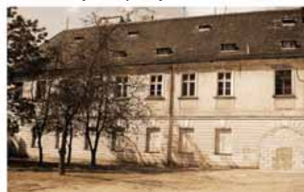
Klasztor, budynek szpitalny.
